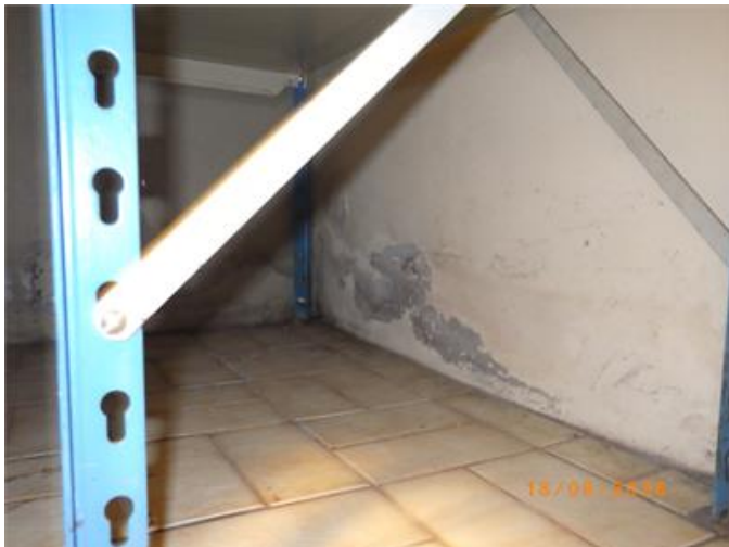
Fuktgenomslag yttervägg källarplan.
