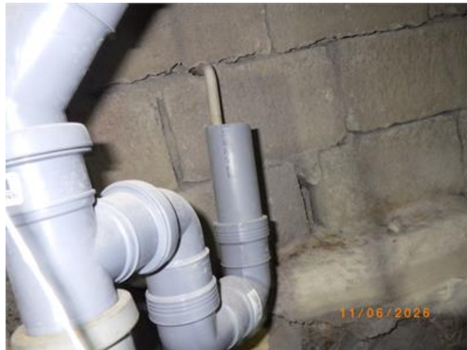
Öppen "ända " i avloppssystemet i krypgrund.
