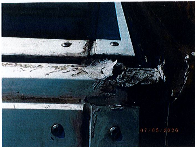
Torkad/sprucken fogmassa glaspartier.
